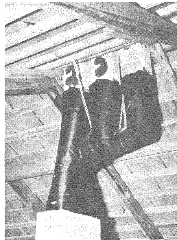
Fig. 13. Kanalforbindelser i loftsrømmet for rygningssystem, god udførelse. Loft ducts of a ridge system, a good construction.
